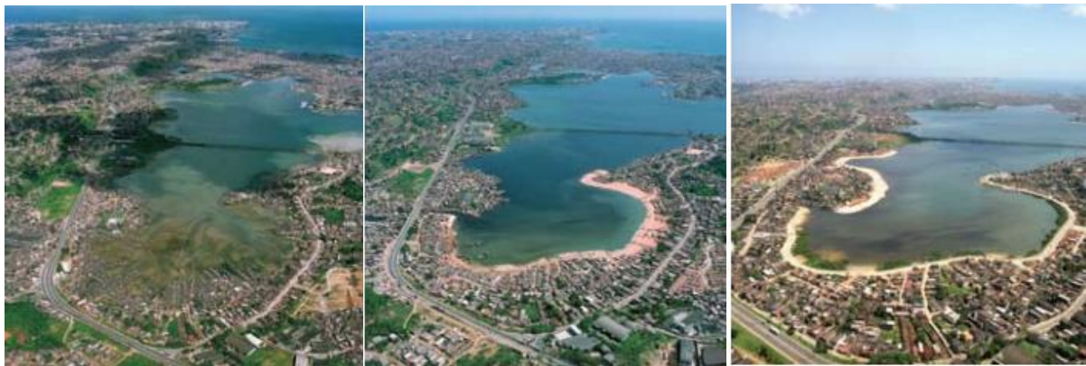
Figura 2 – A Enseada do Cabrito antes do processo de recuperação, durante e depois da remoção das palafitas dos Novos Alagados e a recolocação dos moradores na região. Fonte: CONDER
