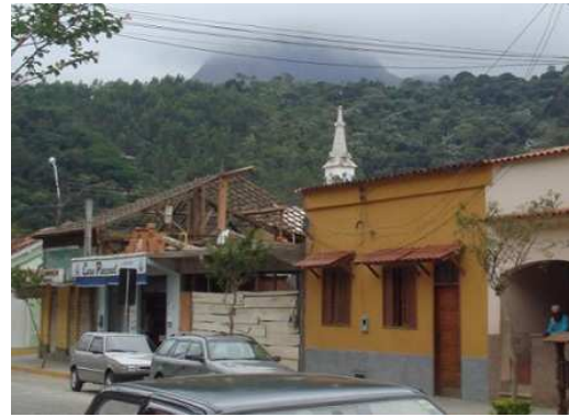
Figura 5 - Casa verde demolida. Outubro 2010.
