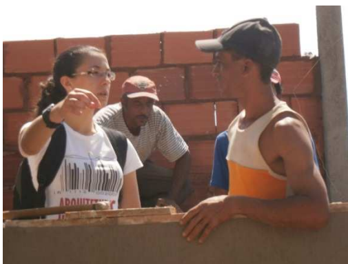
Figura 1 | Natália Karnauchovas auxiliando o servente de pedreiro na obra de sua cliente, Maria Aparecida.
